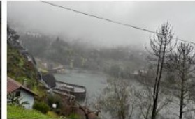
Barragem da Encosta da Caniçada
