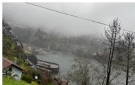
Barragem da Encosta da Caniçada
